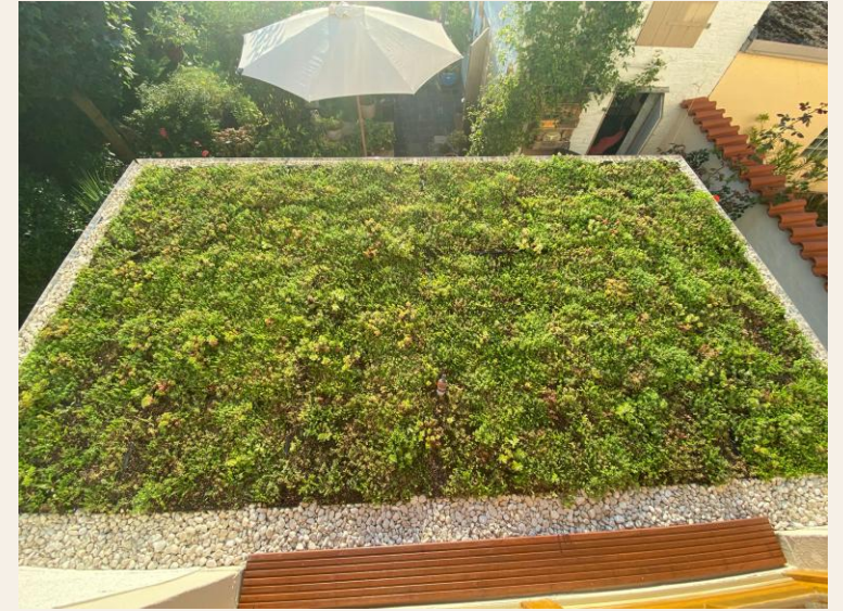
EIN KLEINES DACH
