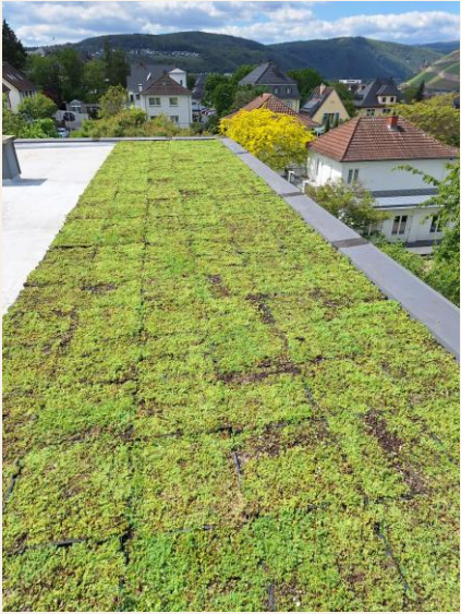
AM TAG DER VERLEGUNG
